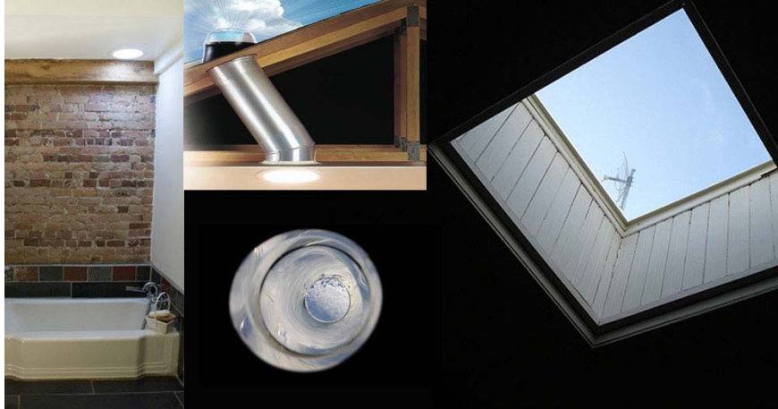
A gauche, lumière d'un puits tubulaire. Au centre : puits tubulaire sous deux angles. A droite : puits classique. Crédit photos : Écohabitation, Solatube, Zaziepoo, Creative Commons.
